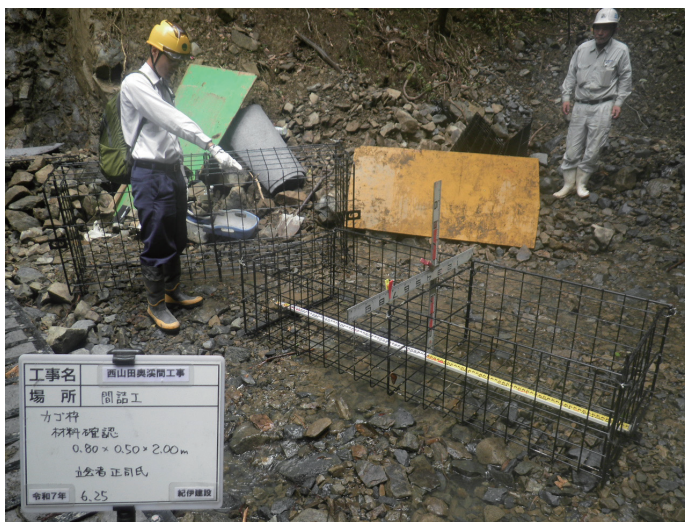
治山工事における監督業務（材料確認）の様子
