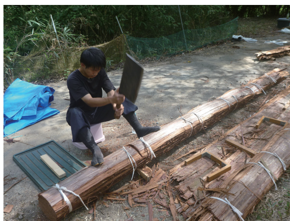
大切包丁で束ねた檜皮を切断する様子
