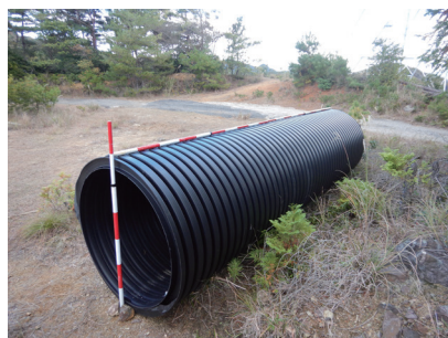
大型排水管（埋設前、サイズ確認）
