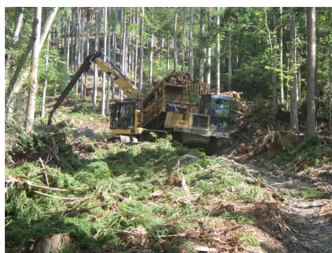
伐木集造材の作業
