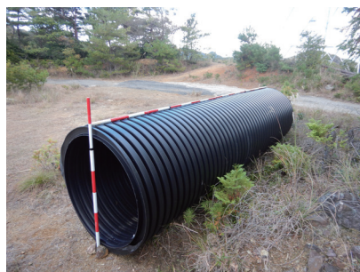
大型排水管（埋設前、サイズ確認）
