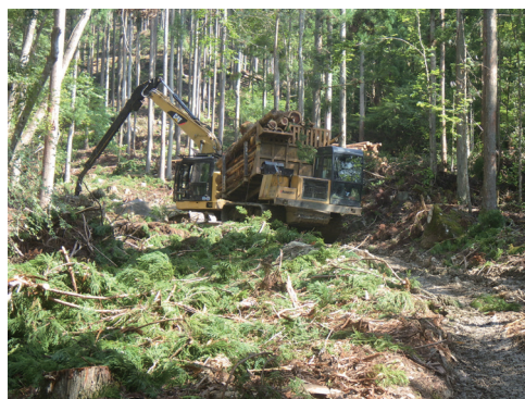
伐木集造材の作業
