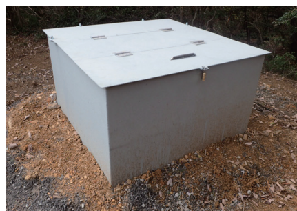
大型排水管完成時の外観
