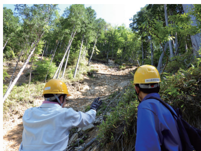
山腹崩壊地の確認
