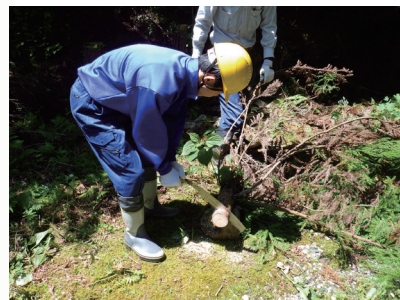
林道支障木の処理
