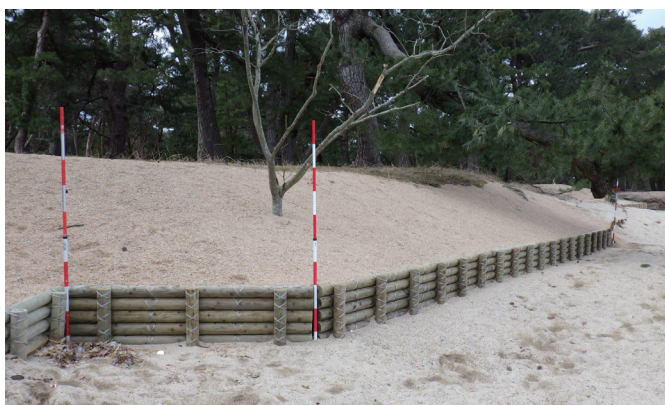
砂の流出を防ぐ養浜工（松原国有林）
