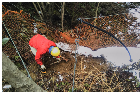
防護柵の土砂撤去
