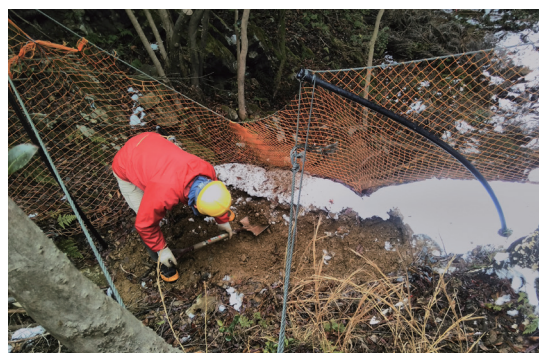
防護柵の土砂撤去
