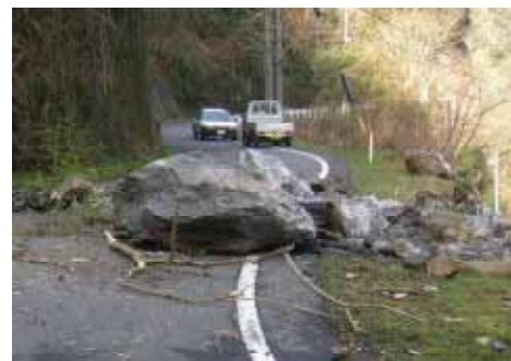
【落石による県道の被災(岡山県備中町)】
