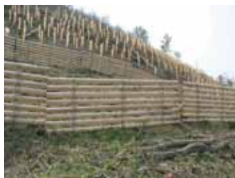
木製防風柵と植生保護管の設置状況
