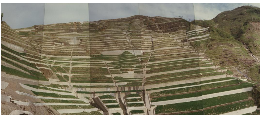
施工状況（昭和54年頃）
