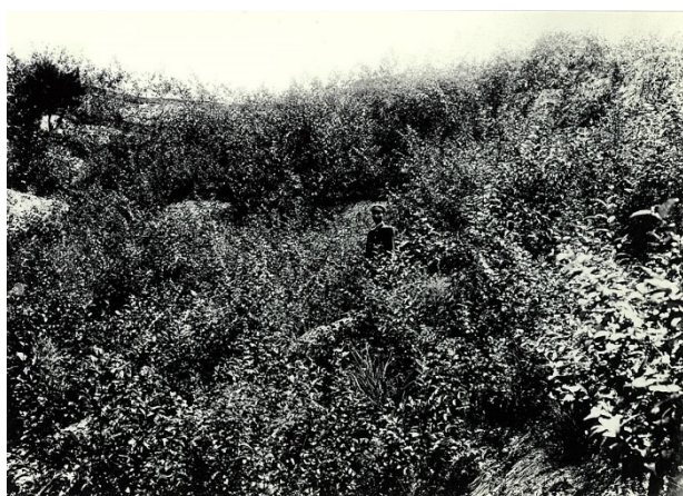
施工後3年経過、大正6年
