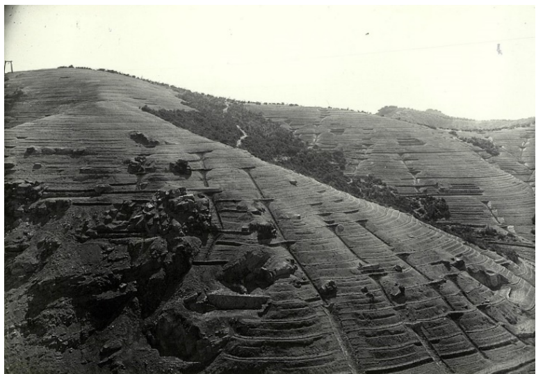
田上山、施工後、大正5年
