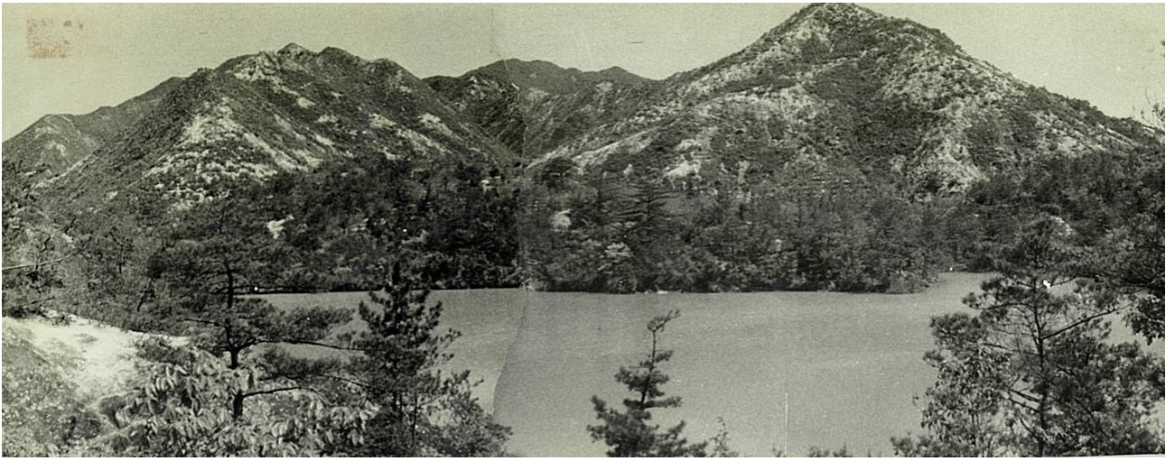
施工前、昭和29年【姫路署】
