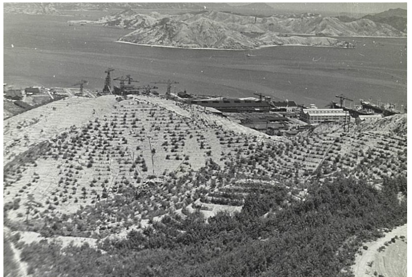
施工後、玉野港をのぞむ
