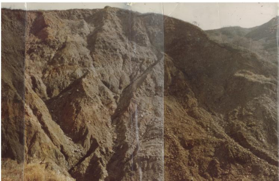
施工前（昭和38年頃）
