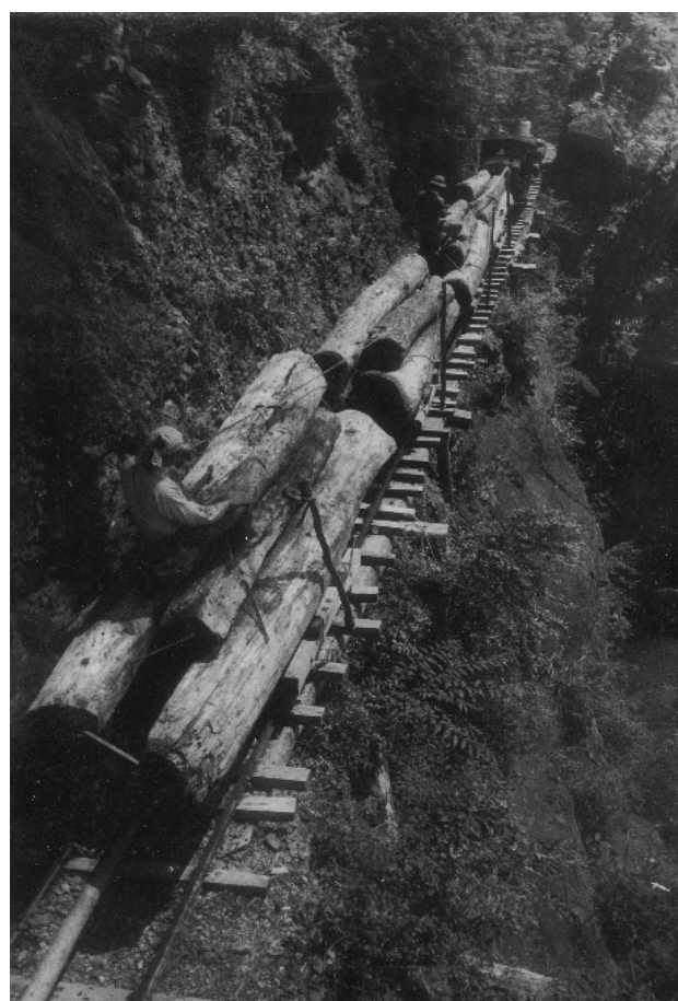
軌道トロリーを牽引する
