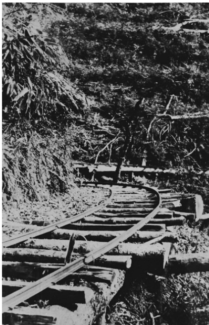
完成直後の軌道
