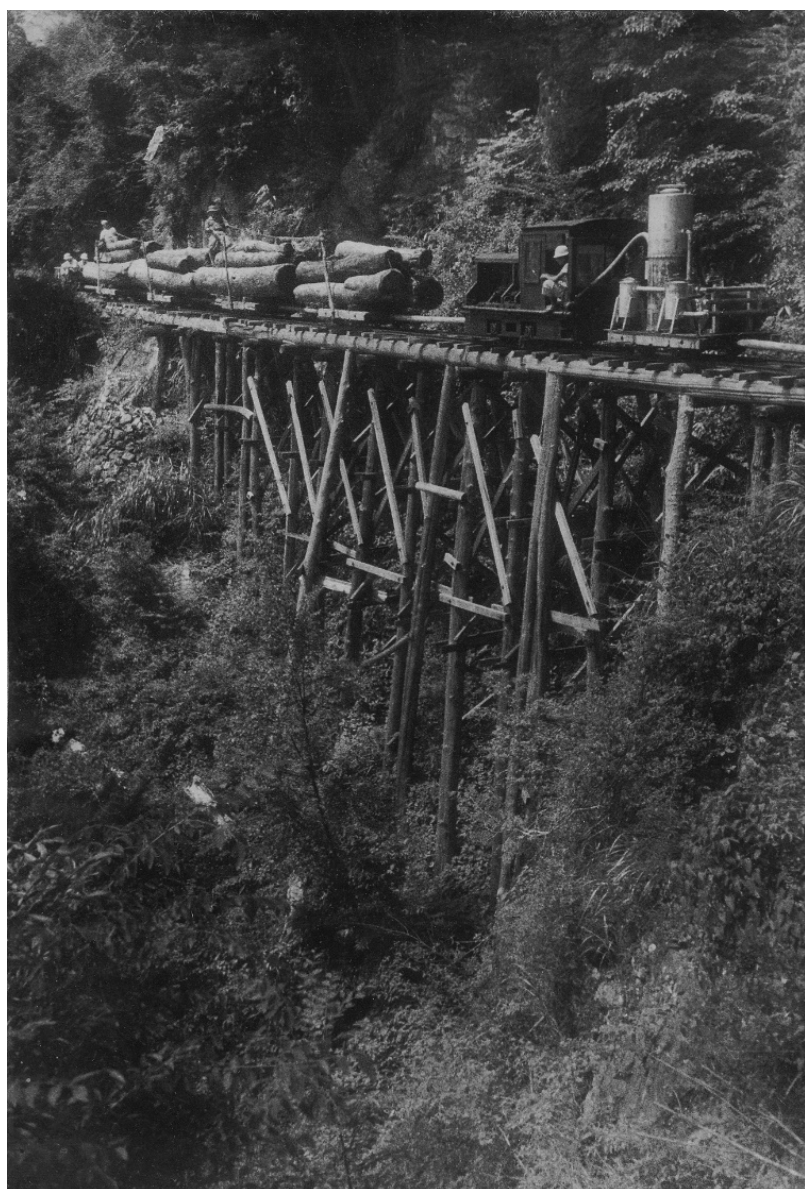
高栈橋の上を通過する機関車
