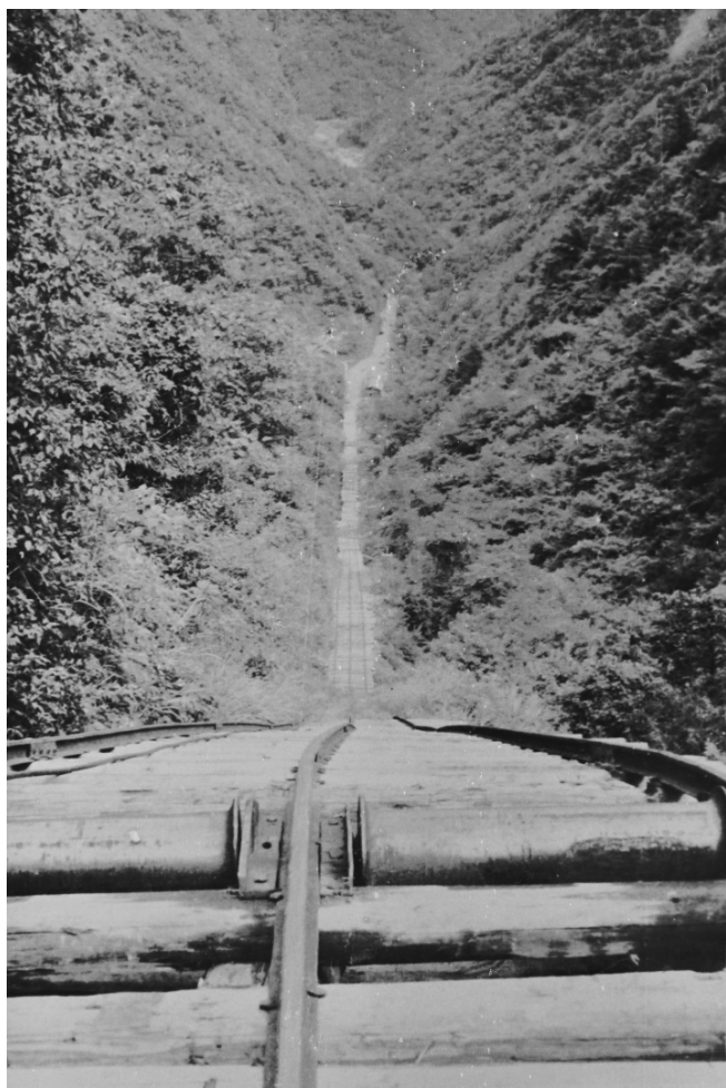
不動谷斫伐作業所が設置した 巻取式ドラムによるインクライン
