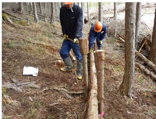
写真－8 横木の組み立てと杭打ちの状況
