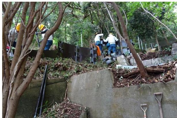
写真－7 職員による土留鋼板施工
