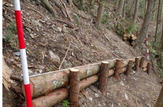
写真-2 丸太筋工の状況
