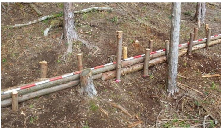
写真－9 試作完了の状況（挟込式丸太筋工）
