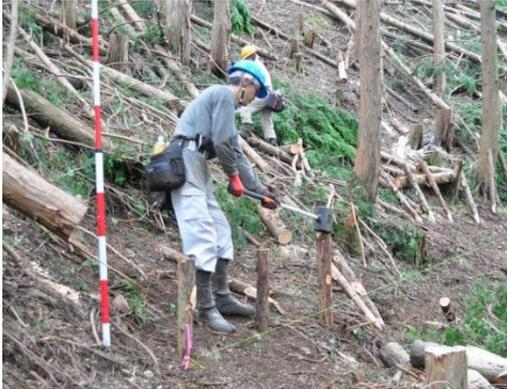
写真-25 杭の打ち込み状況
