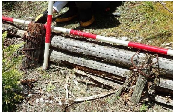
写真-4 腐朽した丸太筋工
