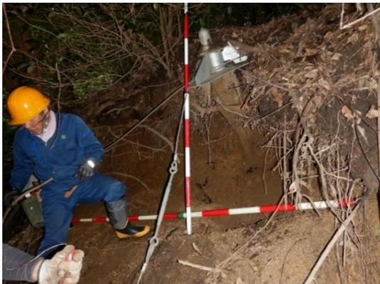
写真－5 露出した鉄筋挿入工
