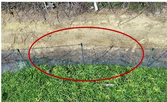
写真-4 動物の絡み、ネットの破れの確認
