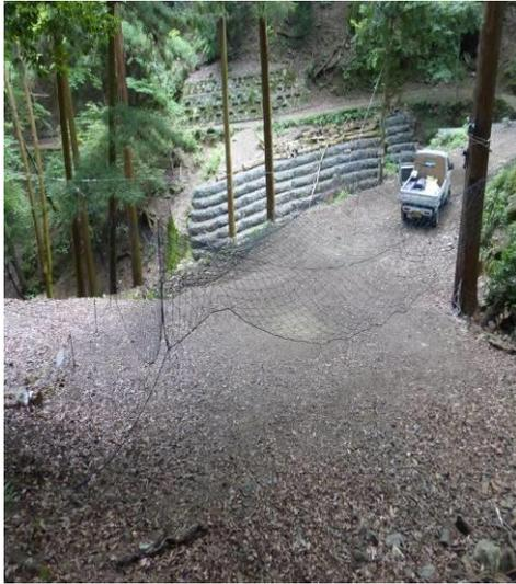
写真-1 ドロップネット設置全景
