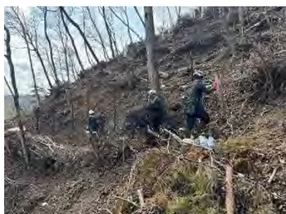
写真－13 パッチディフェンス施工中
