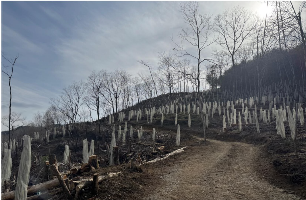
写真-22 竣工写真
