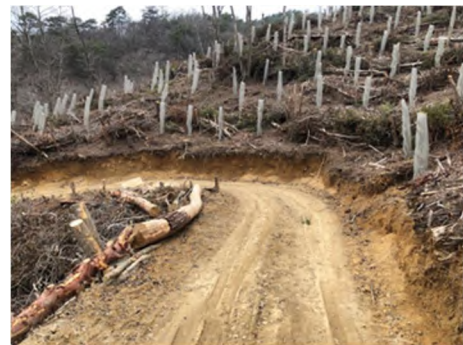
写真－8 作業道（幅員2.5m）
