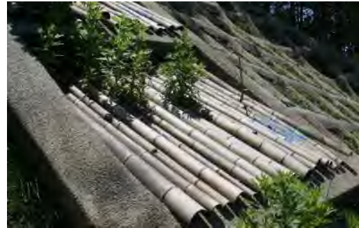
写真-1 竹被覆工写真
