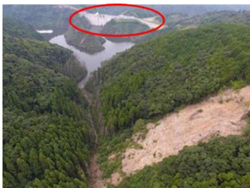
写真－2 崩壊地とダム（赤丸囲い）
