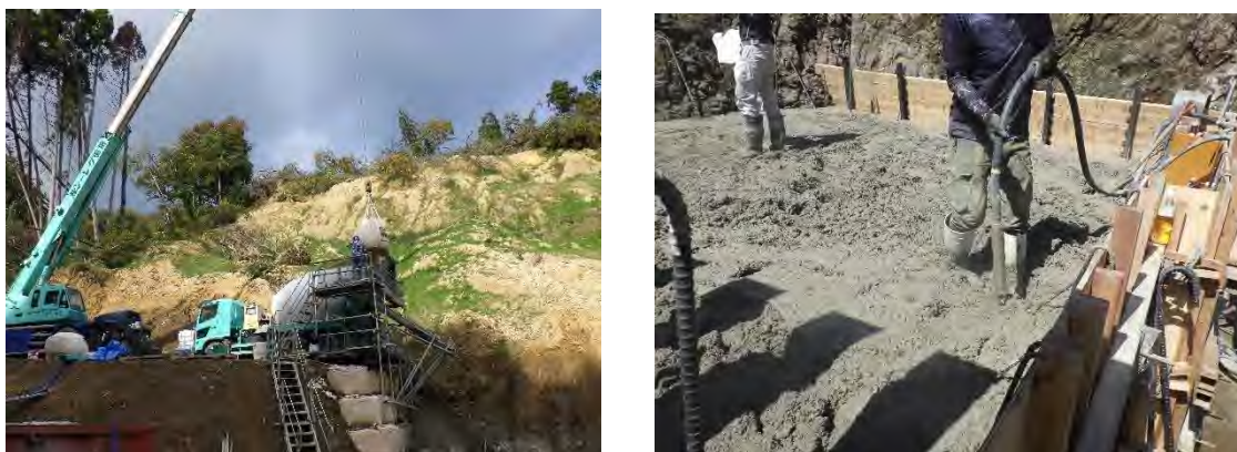
図-9 ドライミックスコンクリートの練り混ぜ、打ち込み状況
