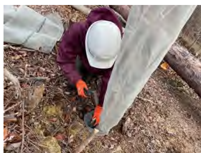
写真－14 チューブラー施工中
