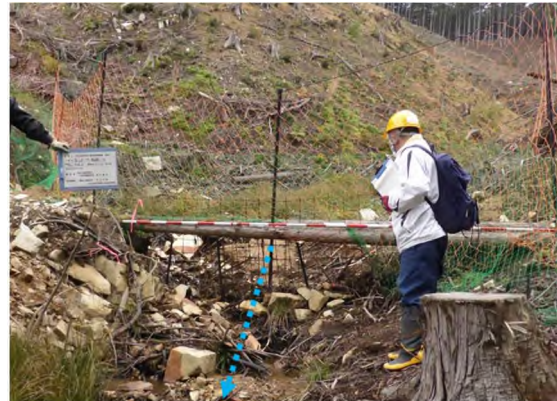
写真-3 ワイヤーメッシュ設置状況
