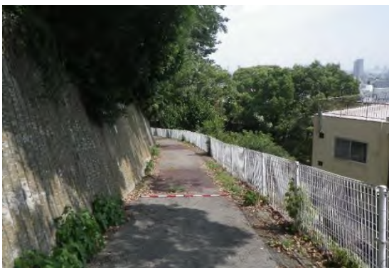
写真 - 3 長尺材が搬出困難な現地状況
