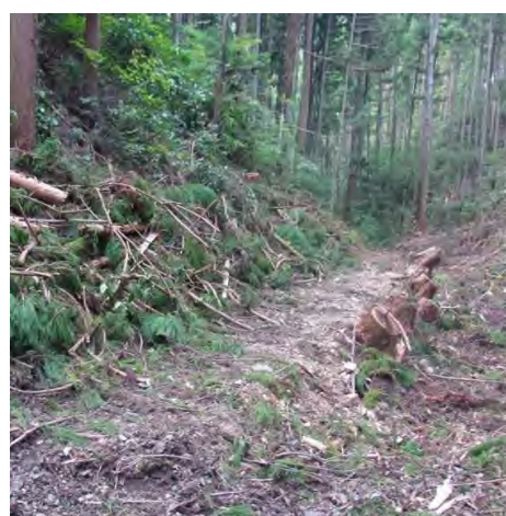
写真-1 間伐時に作設された作業道
