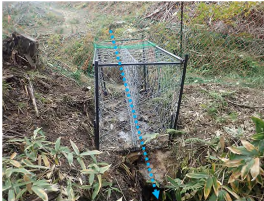
写真-2 ふとんかご設置状況
