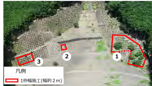
図-2 下モ谷試験区の全景 (令和7年5月)
