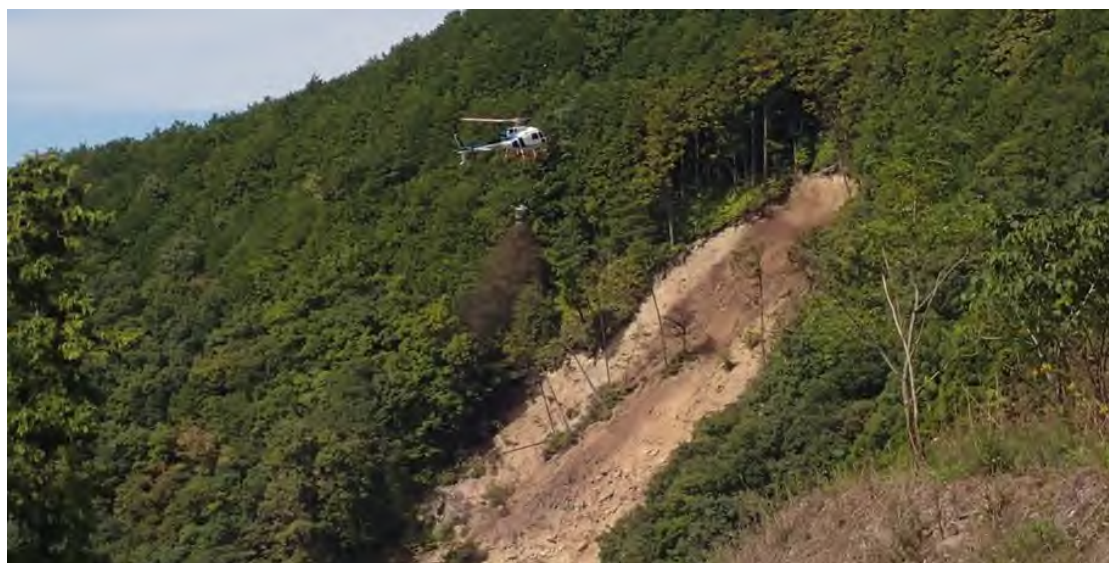
写真－4 航空実播施工中
