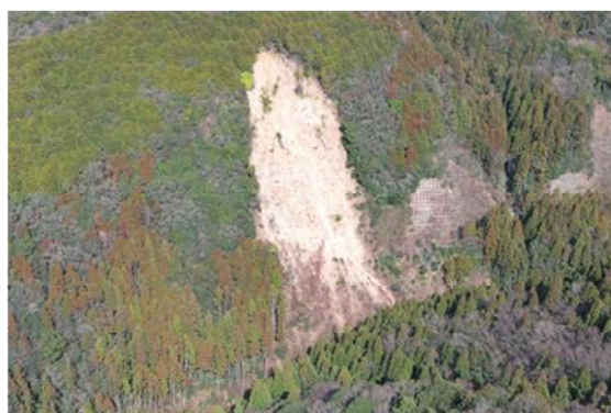
写真－3 崩壊地（令和6年2月撮影）
