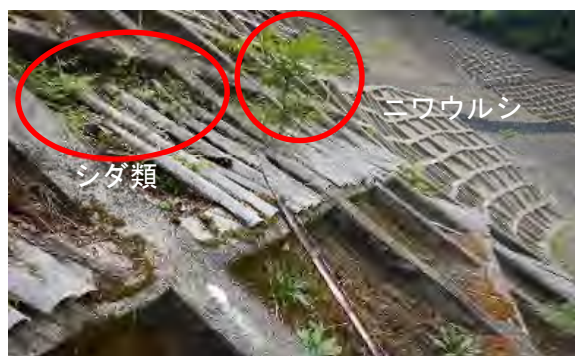
写真-10 竹の隙間から植物が生育している 様子(令和7年5月)
