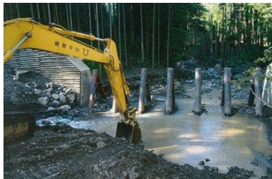
（国有林スリットダムに堆積した流木等の除去の様子）
