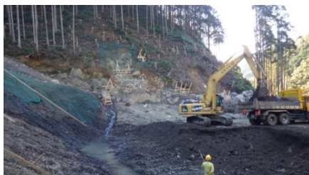
（上流の県施工の様子）
