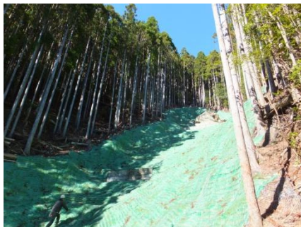
（国有林で施工した山腹工事）
