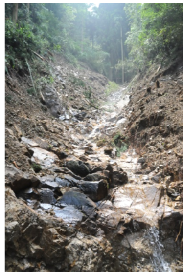
写真 12 福田上八保の斜面崩壊の流走域
