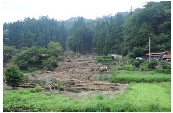
写真 10 福田上八保の斜面崩壊の堆積域
