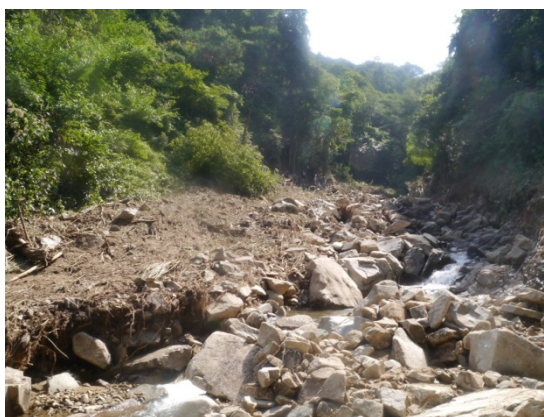
写真 16 崩壊地流下部の上流側
