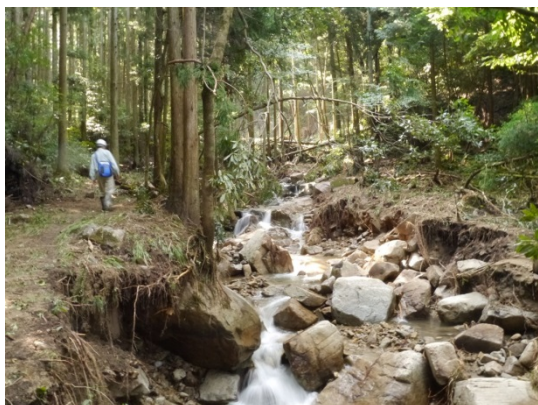
写真 11 流石川の崩壊地の下流側
