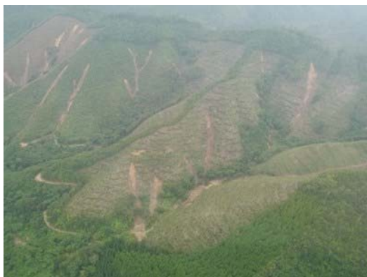
写真 7 名賀地区北部の崩壊
