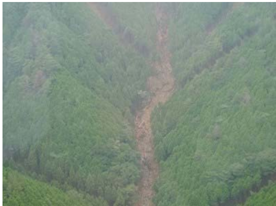
写真 9 名賀地区南部の崩壊
