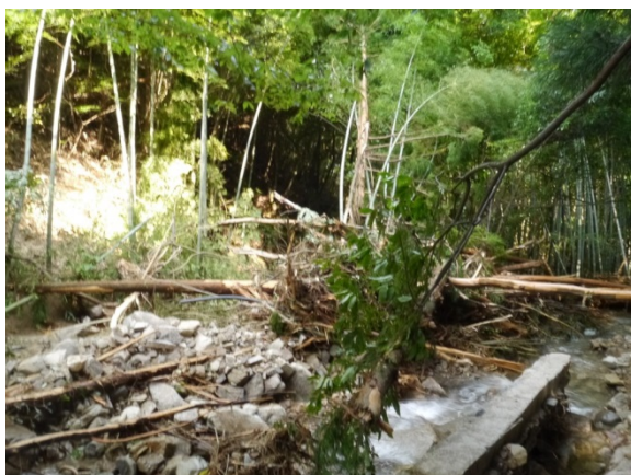
写真 19 国道 9 号線への出口付近
