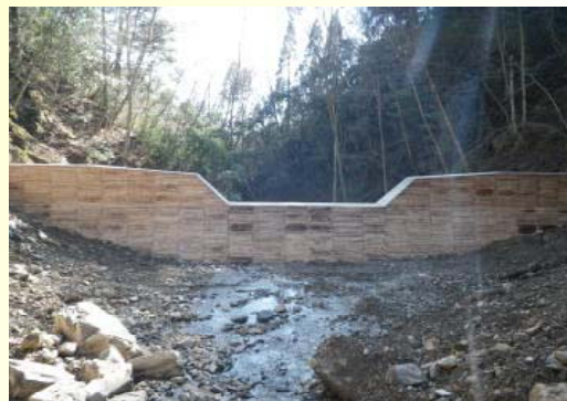
(木製型枠を利用した谷止工)
