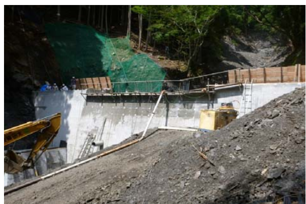
復旧工事の様子（奈良県十津川村）
