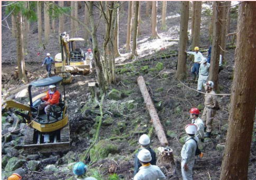
(森林作業道作設オペレーター研修の様子)
