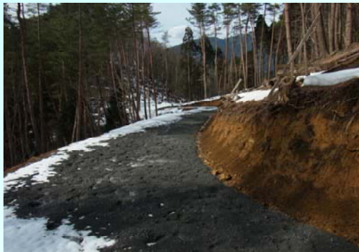
(民有林内に新設した林業専用道の様子)
