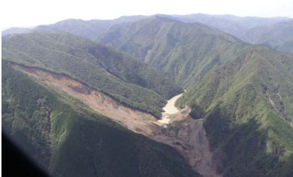
大規模な山腹崩壊の様子（奈良県五条市）
