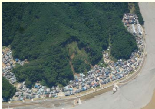
(民家と隣接する国有林の空中写真)
