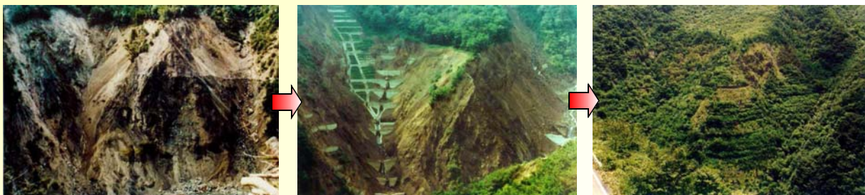
(S46:奈良県民有林直轄治山施工前の様子)
