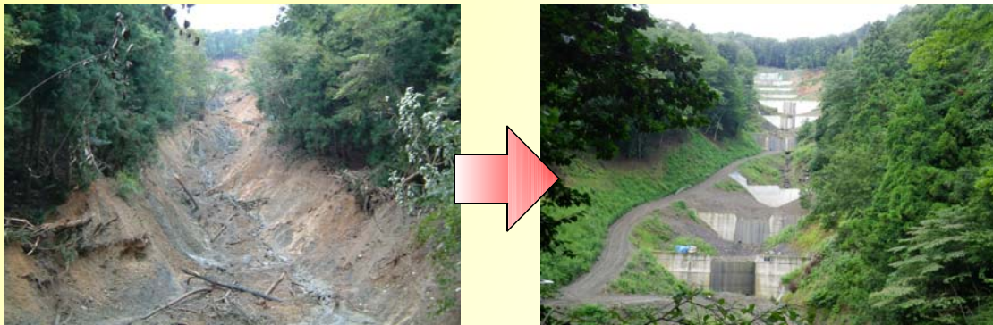
(福井県・一ツ谷国有林での復旧の様子)
