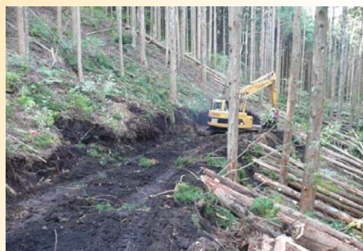
(森林作業道新設の様子)
