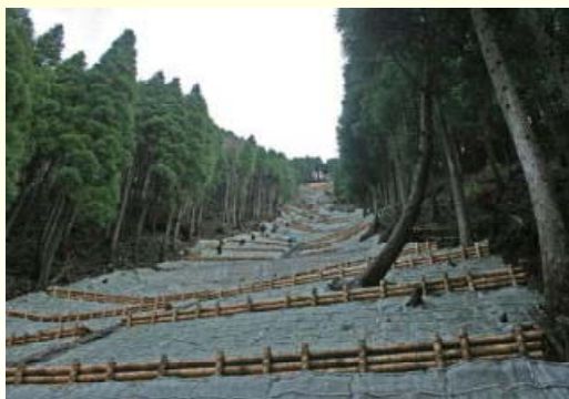
(山腹工事への間伐材使用)
