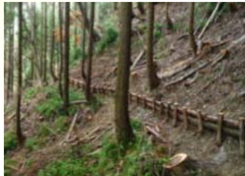
(本数調整伐後の林内の様子・伐採木を筋工に活用)
