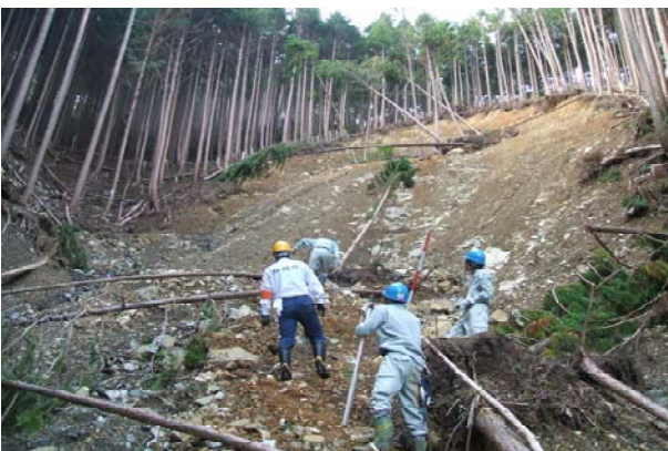
山地災害対策緊急展開チームによる測量調査の様子
