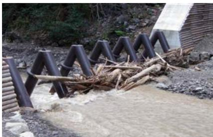
（最下流の国有林スリットダムに堆積した流木の様子）
