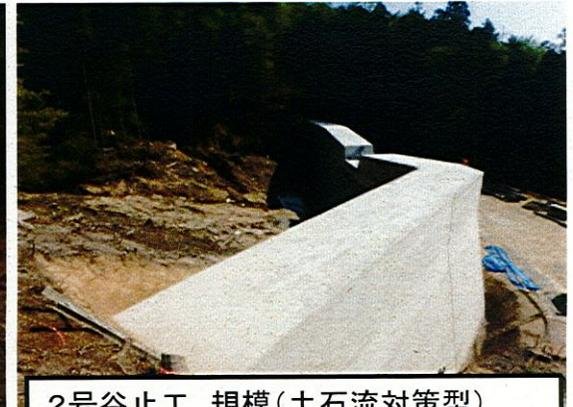
2号谷止工 規模(土石流対策型)
