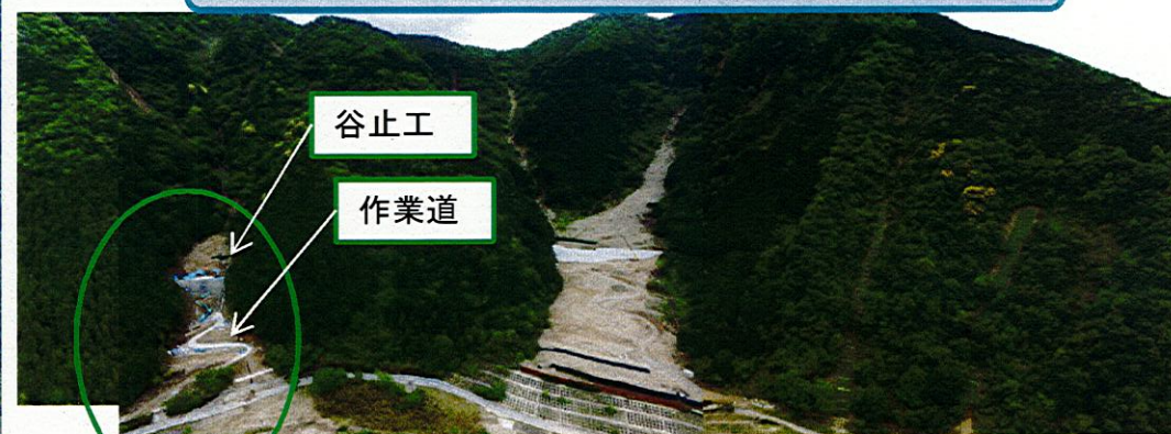
谷止工完成状況(平成28年5月11日現在)
