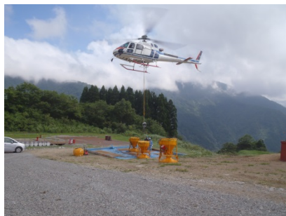
【ヘリによる施工状況】
