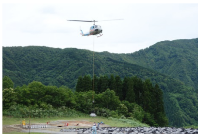
【ヘリによる施工状況】
