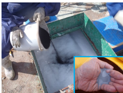
【侵食防止工用資材の作製状況】
