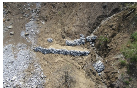
【ヘリによる施工完了状況】
