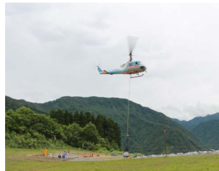
【ヘリによる施工状況】
