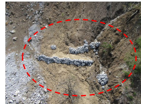
【袋型土留工設置状況】
