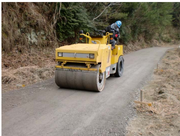
鉄鋼スラグ路盤工作設(転圧作業)の様子
