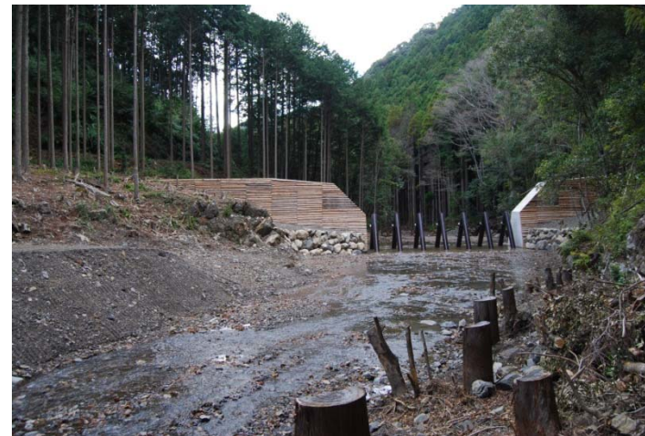
谷止工(スリットダム)設置の様子
