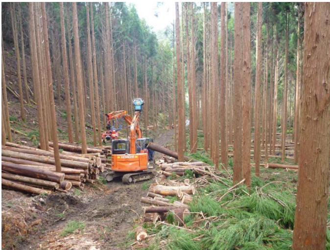
集造材作業の様子
