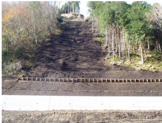
治山工事への県産材利用の様子
