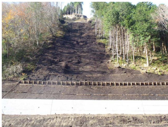
治山工事への県産材利用の様子
