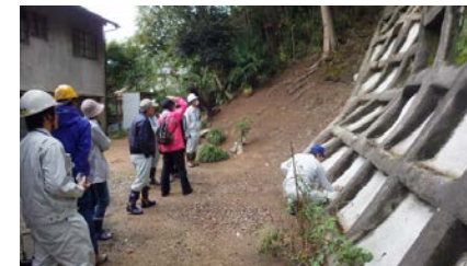
(民有林の治山施設点検の様子)
