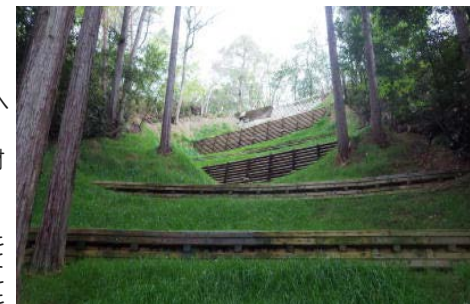
（治山工事への県産材利用の様子）
