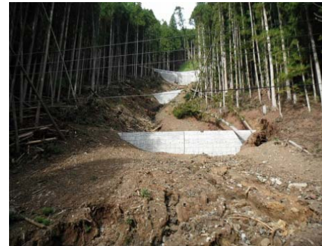
【天川村川合地区の復旧の様子】
