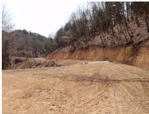
森林共同施業団地内の林業専用道の新設
