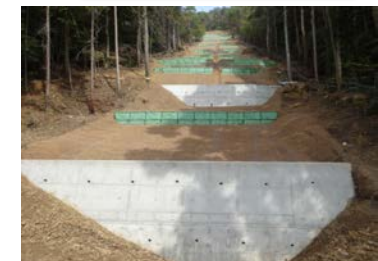
災害対策工事完成写真 (野洲市 三上山国有林)
