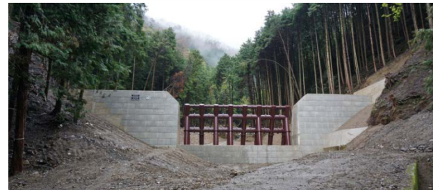
災害対策工事完成写真(大津市 関寺国有林)
