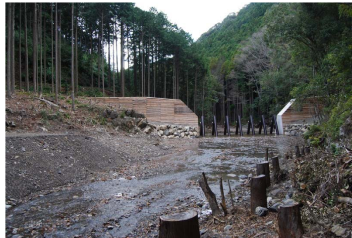
谷止工(スリットダム)設置の様子
