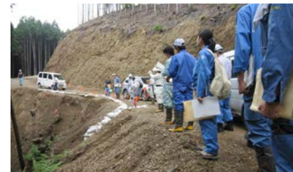
（路肩決壊箇所の原因を分析する様子）
