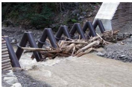
（最下流の国有林スリットダムに堆積した流木の様子）
