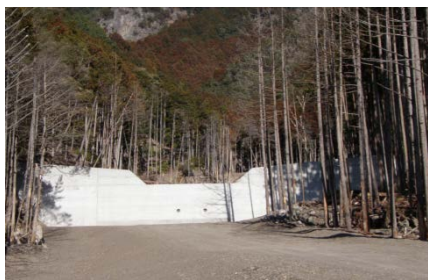
（上流の県施工ダムの様子）
