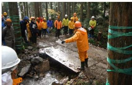
（鉄板を利用した簡易橋施工の様子）
