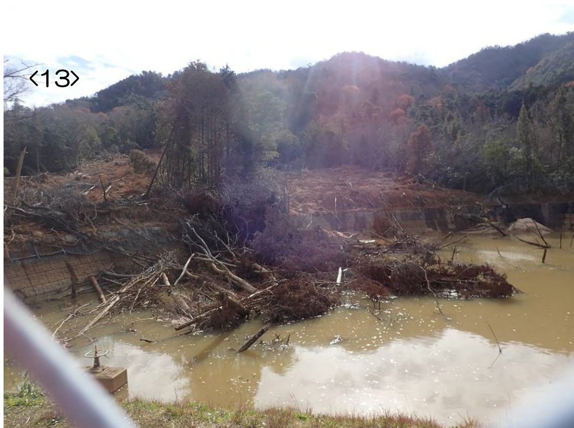
写真 13-15 ため池による土石流の捕捉
