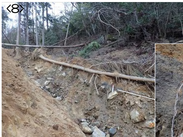
写真 13-8 溪床の侵食跡
