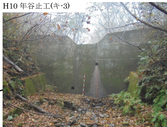
H10 年谷止工(キ-3) 上流側未満砂
