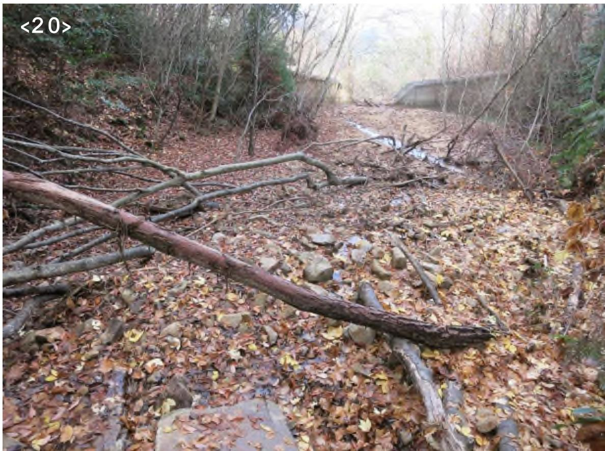
写真 10-19 堰堤による土石流の流下の抑制状況
