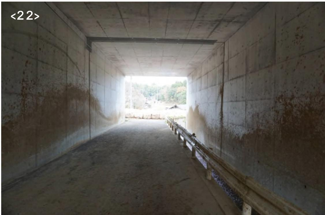
写真 10-21 高速道路盛土の C-BOX から下流側へ流下した痕跡
