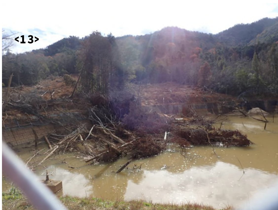
写真 13-15 ため池による土石流の捕捉
