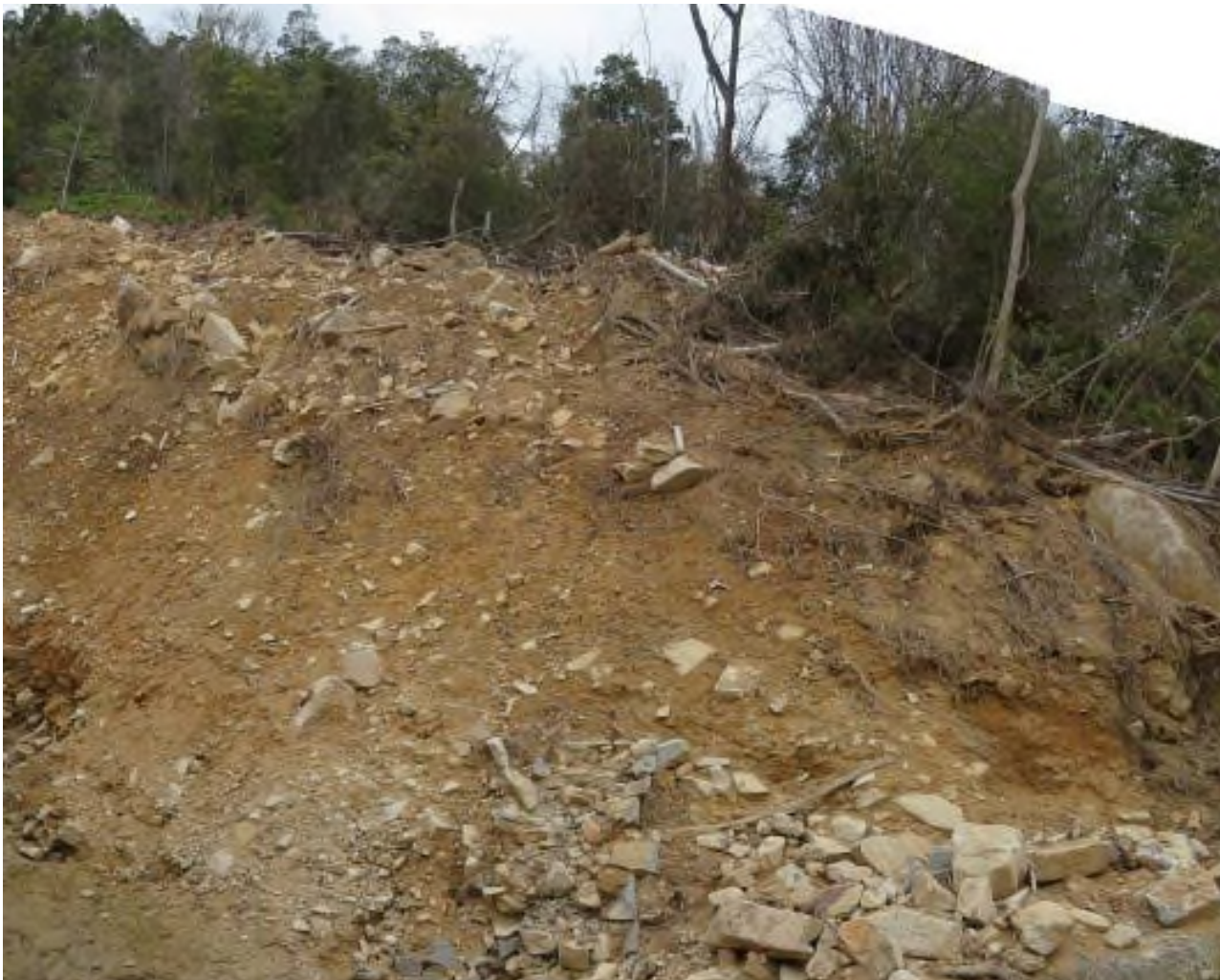
土石流による岩屑堆積物や緩んだ岩盤起源の巨石
