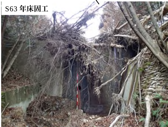
S63 年床固工 堆砂状況
