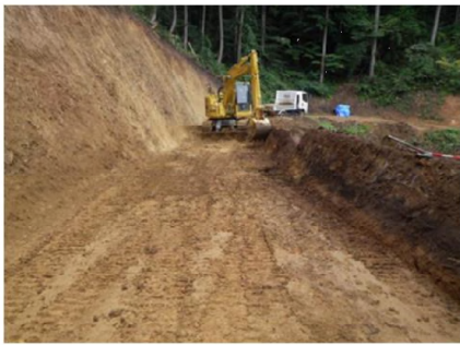
既設作業道を利用し切盛土量を抑え新設延長を確保
