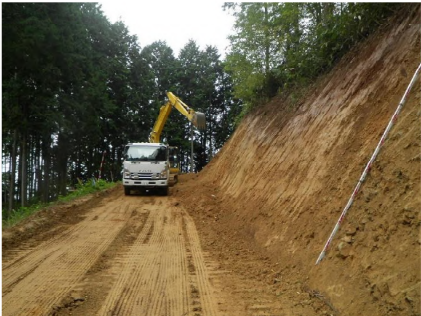
既設作業道を利用し切盛土量を抑え新設延長を確保
