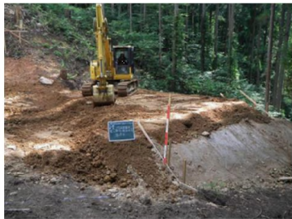
既設作業道を利用し切盛土量を抑え新設延長を確保
