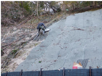
金網付マット伏工、植生マット伏工作業状況
