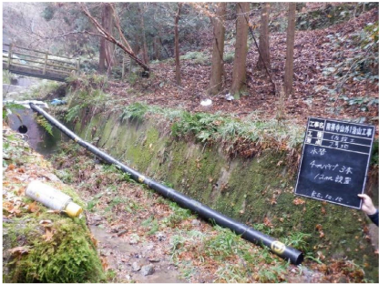
廻排水施工状況
