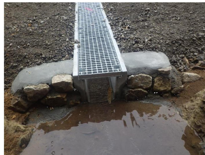
呑口部に現地発生材を活用
