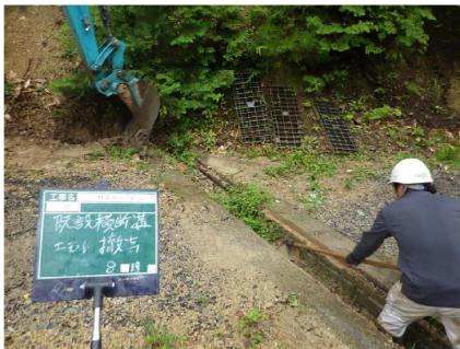
既設横断溝の土砂撤去
