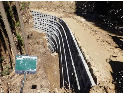
きれいな曲線に仕上げたコンクリートもたれ擁壁
