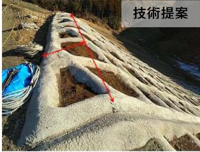
法枠工路肩部分を巻き込み法肩部の安定性向上
