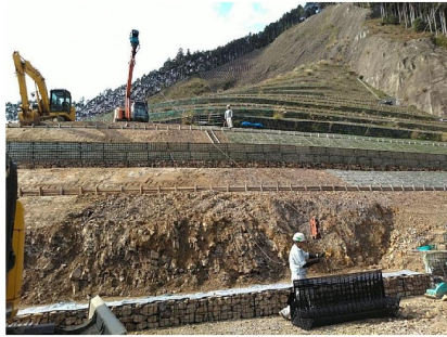
簡易ケーブルの代替としてスイングヤード活用
