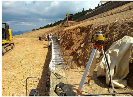
レーザーレベルを使用し作業効率化
