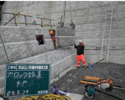
残存化粧型枠施工状況
