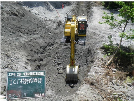
ICT機械施工による掘削作業
