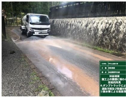
散水車による路面清掃
