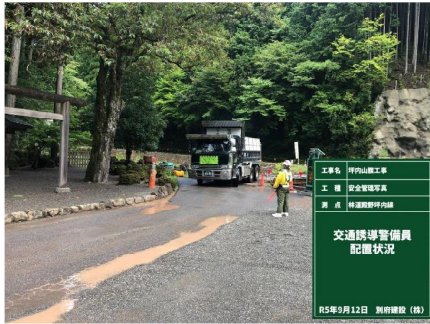
警備員を複数配置し安全確保のうえ土砂運搬実施
