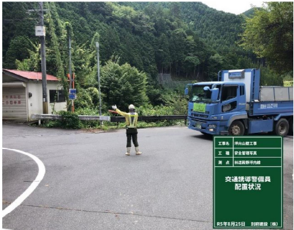
警備員を複数配置し安全確保のうえ土砂運搬実施
