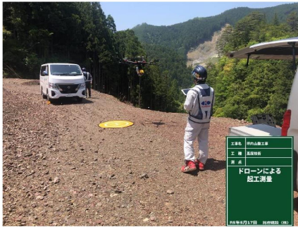
UAVによる起工測量及び出来形管理測量
