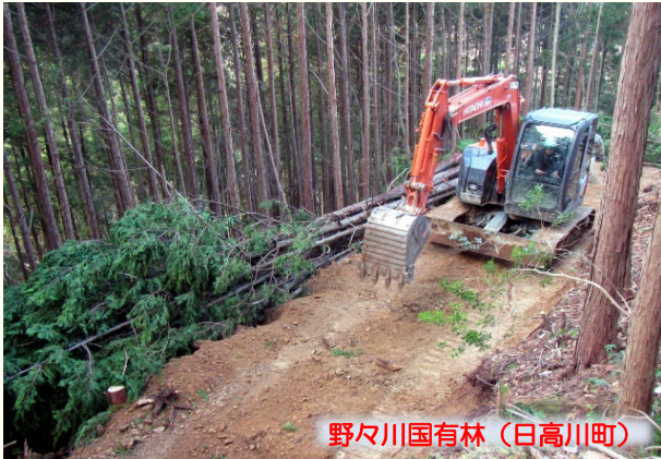
【バックホウによる森林作業道作設】
