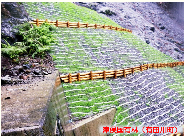
【間伐材を利用した山腹工】
