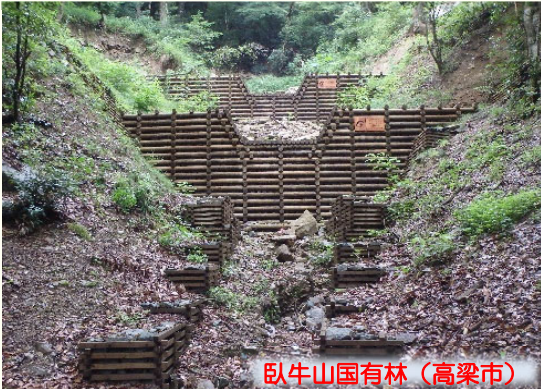
【自然環境に配慮して治山ダムに木材を利用】
