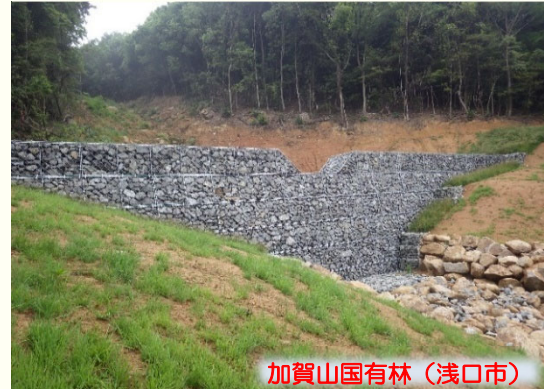
【荒廃した溪流への治山ダム設置】
