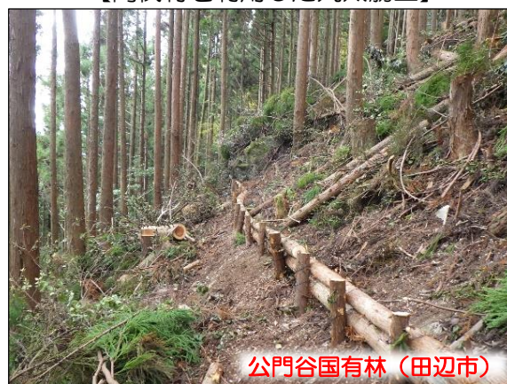
【間伐材を利用した丸太筋工】
