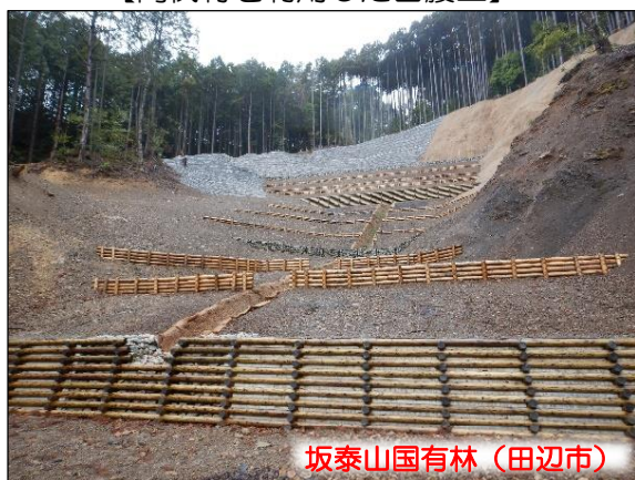
【間伐材を利用した山腹工】
