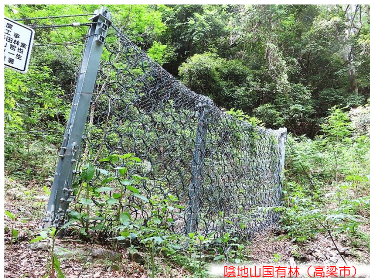
【荒廃した溪流に施工した溪間工】
