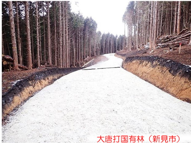
【開設した林業専用道】
