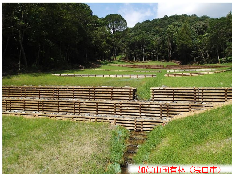
【間伐材を利用して施工した山腹工】
