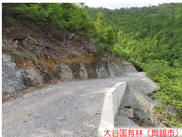
【開設した林業専用道（作業道格上げ）】
