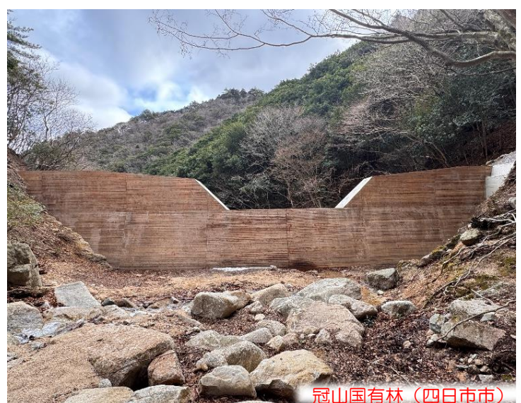
【木材を利用して施工した溪間工】
