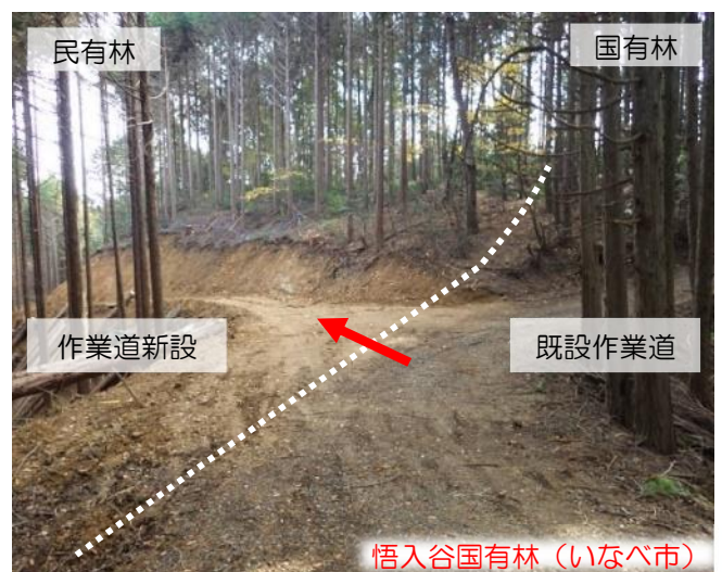
【民有林連携した作業道（民有林作業道新設）】
