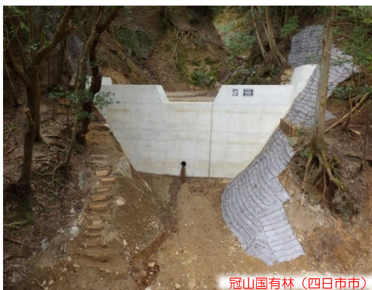
【荒廃した溪流に施工した溪間工】
