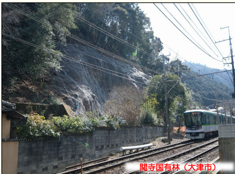
【線路沿いの山腹斜面に施工した山腹工】
