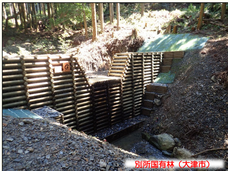
【林道に近い溪流で施工した溪間工】
